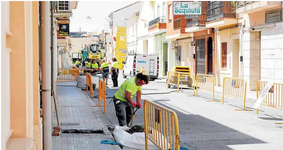
Comienzan las obras de retirada de la tubería que revienta, ayer en El Palmar. JESÚS SIGNES
