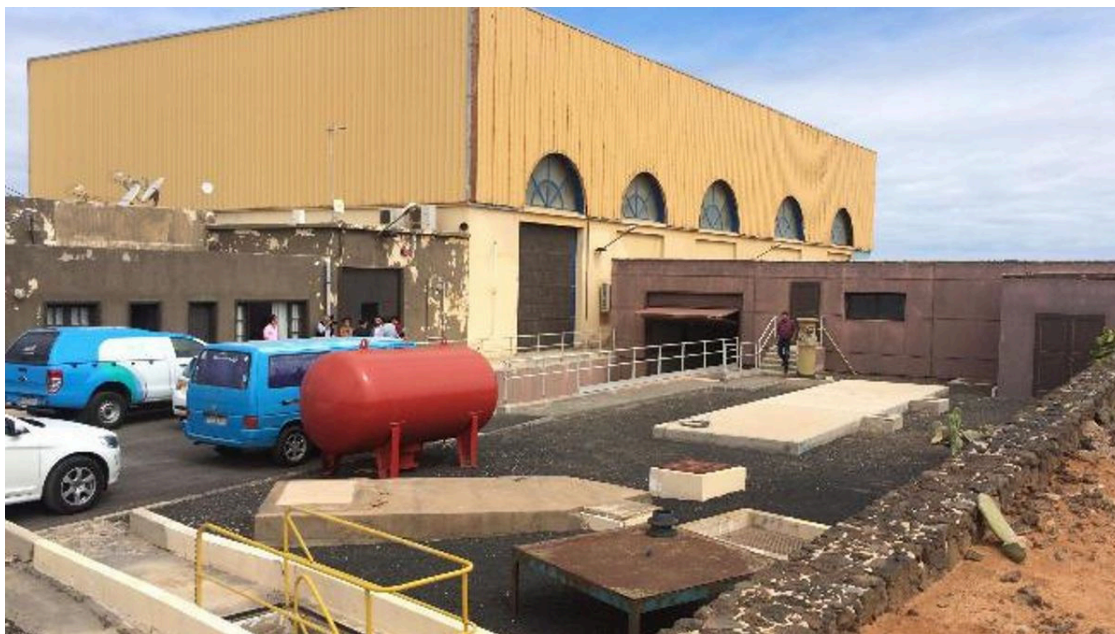
Estación desaladora de Janubio, en el municipio de Yaiza. / La Provincia
